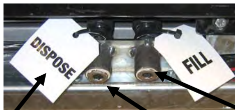
RTI-Kabelanschluss (hinter Entsorgungsschild). Abbildung 1 Frischfettanschluss Altfettanschluss
