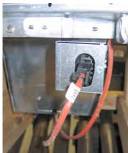
Abbildung 6: Befestigen Sie die zweipoligen weißen Steckverbinder und stecken Sie den schwarzen Steckverbinder wie dargestellt in die Versorgungsdose. * Bitte beachten Sie, dass die Position des schwarzen Steckverbinders vom Foto abweichen kann.
